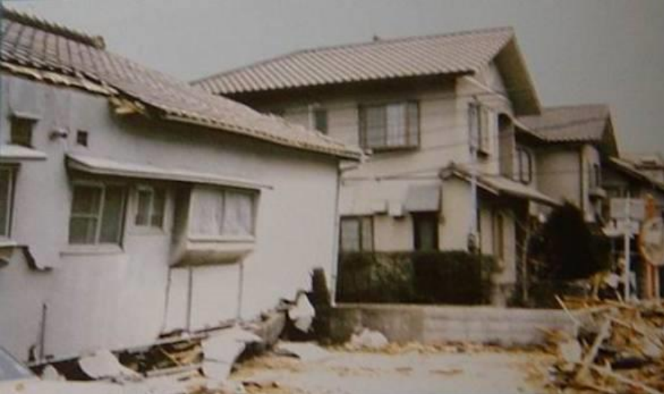
1995年阪神地震（M7.3，6500人死亡）后日本式木结构（前）与北美式轻型木结构（后）对比
